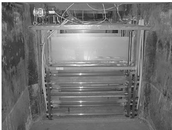
Рис. 12. УФ установка ВОДОГРАЙ В-625-НОК105/80 з лампами середнього тиску та вбудованим механізмом очищення кварцових чохлаів.
