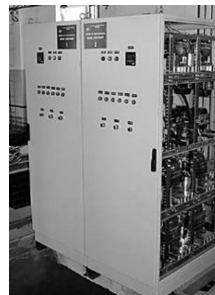
Рис. 12. УФ установка ВОДОГРАЙ В-625-НОК105/80 з лампами середнього тиску та вбудованим механізмом очищення кварцових чохлаів.
