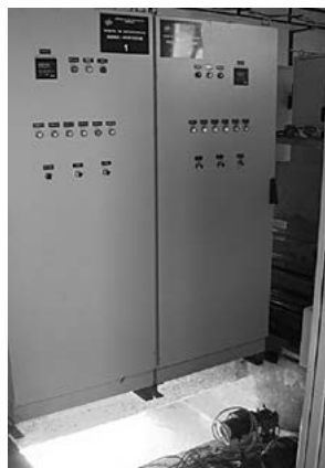
Рис. 12. УФ установка ВОДОГРАЙ В-625-НОК105/80 з лампами середнього тиску та вбудованим механізмом очищення кварцових чохлаів.
