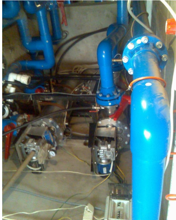
Рис. 4. Фотохимические реакторы в системе оборотного водоснабжения декоративного пруда. Харьков, Сокольники
