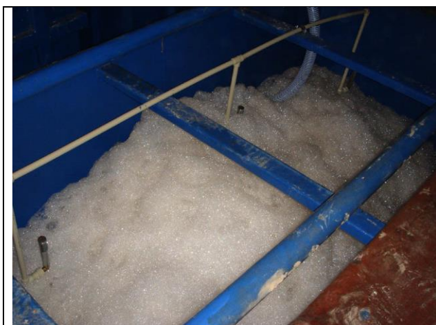
Рис. 3. Процесс пенообразования в барботажной камере (1-я ступень очистки)
