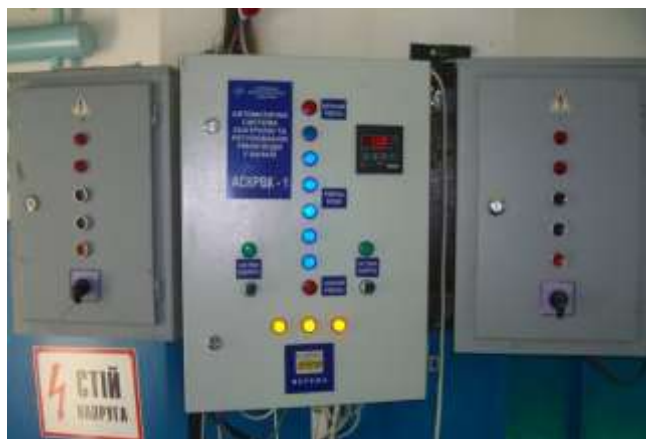
Рис. 8. Шафа управління роботою регулюючої засувки АСКРВК – 1
