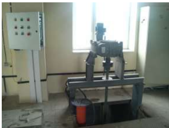
Рис. 7. Засувка для регулювання рівня води у каналі
