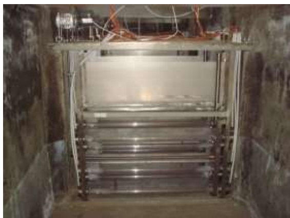
Рис. 9. Знезаражуючі касети В6КС.01 з вбудованим механізмом очищення кварцових чохлаів
