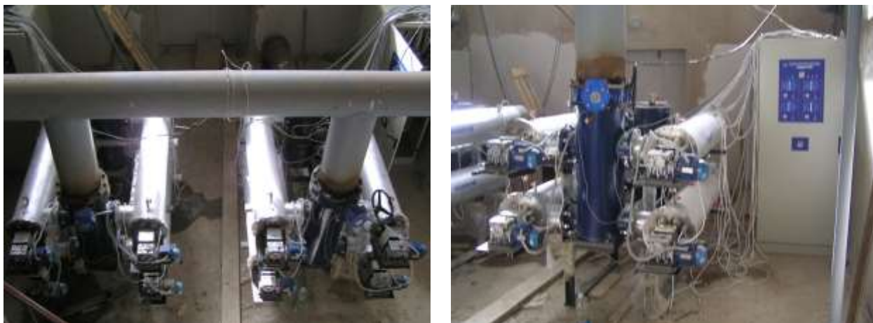
Рис. 4. Установа для знезараження стічних вод корпусного типу продуктивністю 500 \text{ м}^3/\text{годину} з системою механічного очищення кварцових чохлаів
